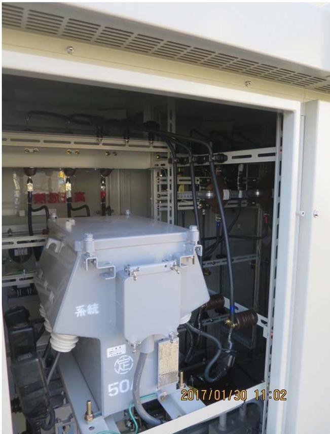
電力需給用計器用変成器は、計器用変成器 (VT) と計器用変流器 (CT) を一体化した構造となっています。
