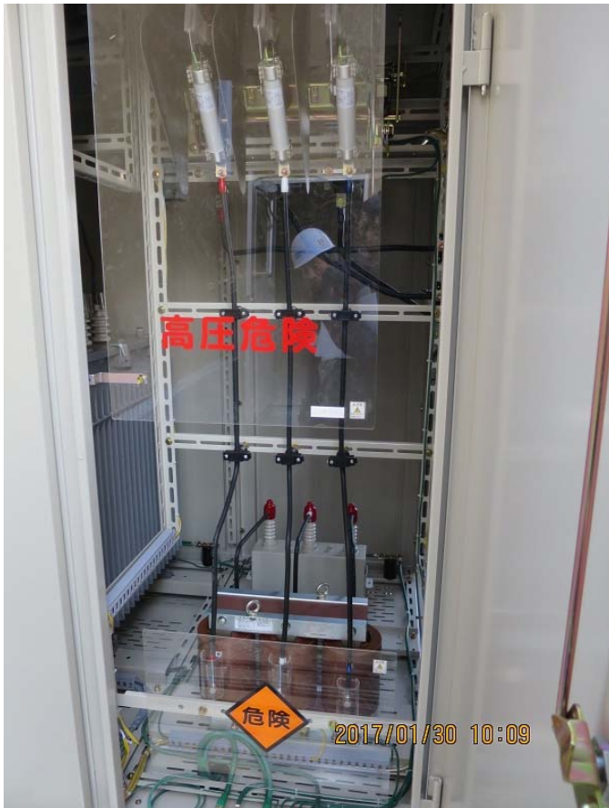
高圧コンデンサ盤 - 内部 -
